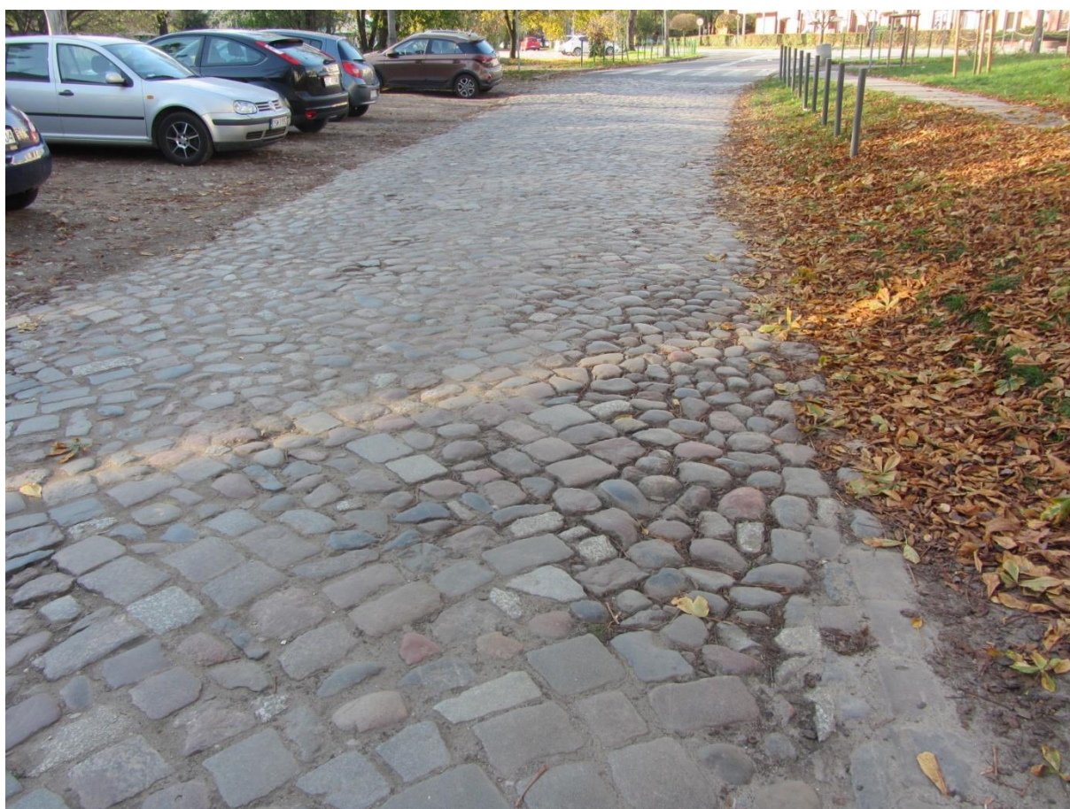
Ulica Urbanowska, nawierzchnia kostki kamiennej rzędowej i kamienia polnego
