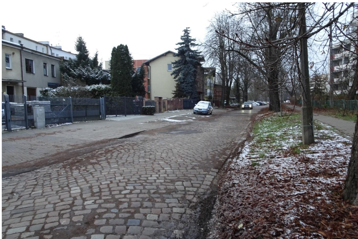
Ulica Urbanowska, nawierzchnia kostki kamiennej rzędowej
